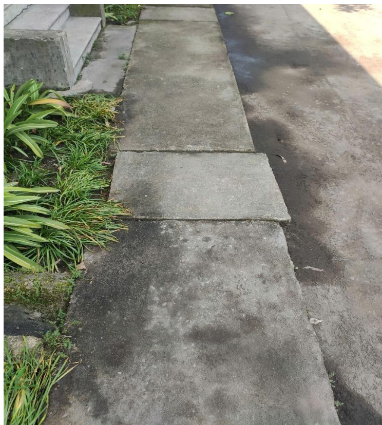
Hình 3.1 Mương thoát nước mặt xung quanh khuôn viên cơ sở
