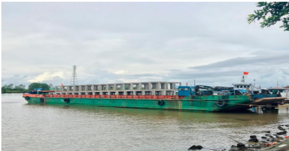
Hình 1.6. Các khối rạn được chất lên sà lan để tiến hành thả rạn
